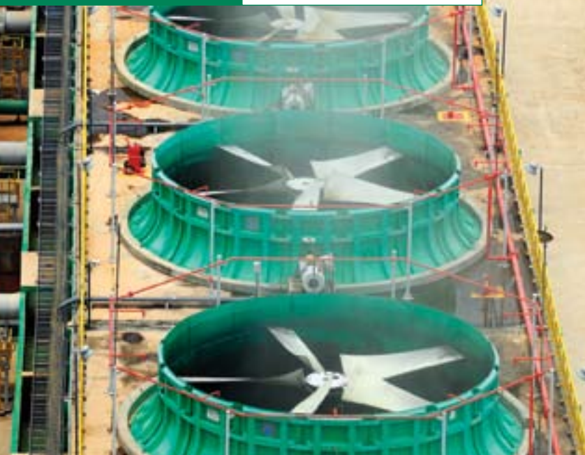
Resfriadores de água da fábrica
